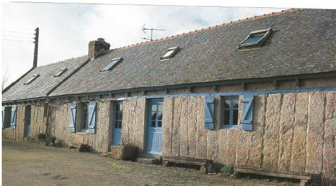
Figure 11 : Une maison en pierre-debout dans la commune de Trégunc. Source : Revue ArMen.
