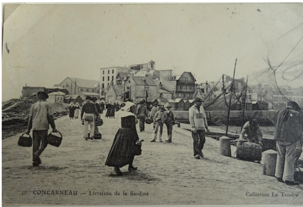
Figure 8. Quai du Port de Concarneau en 1906. Livraison de la sardine. Source : collection privée de Samuel Iglésias.
